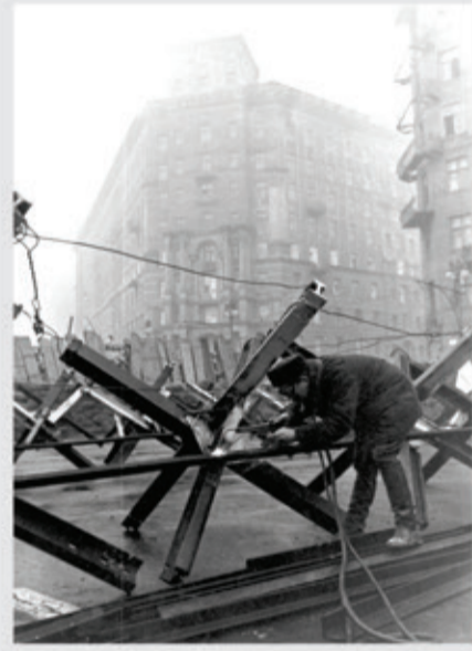
СОТНИ ТЫСЯЧ МОСКВИЧЕЙ РАБОТАЛИ НА СТРОИТЕЛЬСТВЕ ОБОРОНИТЕЛЬНЫХ РУБЕЖЕЙ ГОРОДА. ОБЩИМИ УСИЛИЯМИ ЗА КОРОТКИЙ СРОК МОСКВА ПОКРЫЛАСЬ ГУСТОЙ СЕТЬЮ ПРОТИВОТАНКОВЫХ ПРЕПЯТСТВИЙ, ПРОВОЛОЧНЫХ ЗАГРАЖДЕНИЙ, ДОТОВ И ДЗОТОВ. ПРОТЯЖЕННОСТЬ ПРОТИВОТАНКОВЫХ ПРЕПЯТСТВИЙ, ВОЗВЕДЕННЫХ В САМОМ ГОРОДЕ, ДОСТИГЛА 113 КМ. А ПРОТИВОПОЕХОТНЫХ - 46 КМ. НА НАИБОЛЕЕ ВАЖНЫХ НАПРАВЛЕНИЯХ БЫЛО УСТАНОВЛЕНО 24 ТЫС. МЕТАЛЛИЧЕСКИХ ПРОТИВОТАНКОВЫХ ЕЖЕЙ. ЗНАЧИТЕЛЬНАЯ ЧАСТЬ УЛИЦ БЫЛА ЗАБАРРИКАДИРОВАНА.
